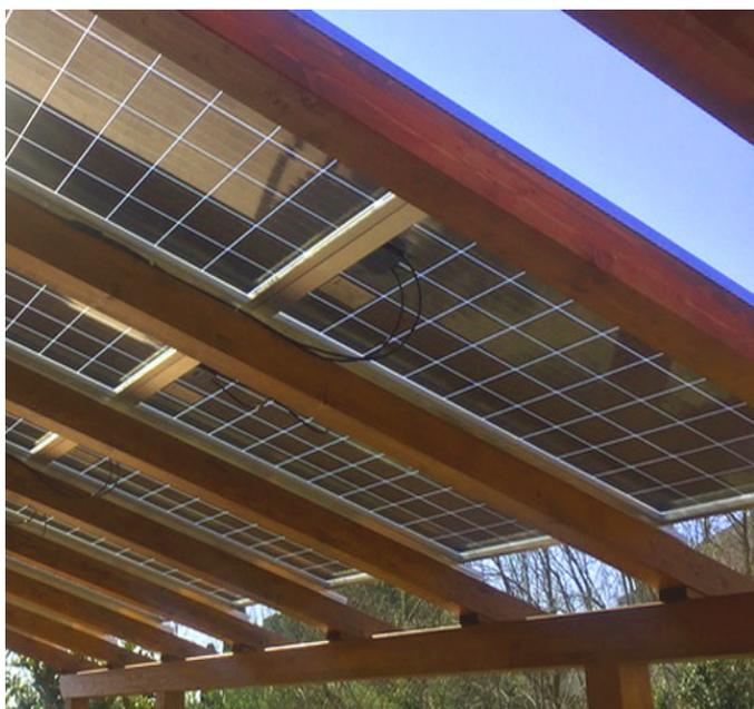
con pannelli monocristallini: 7-9 metri quadrati per Kw installato
